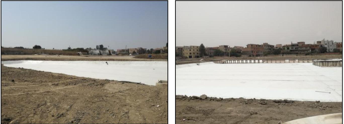
Figure 7. Photos de la mise en place du géotextile
