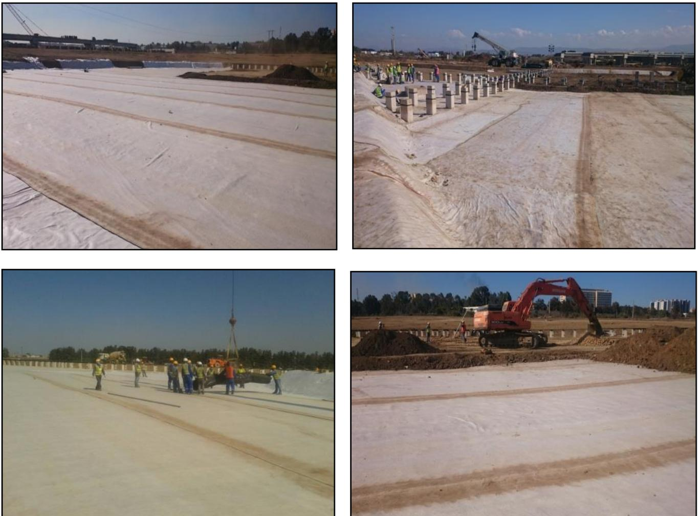
Figure 8. Photos de la mise en place du GSB
